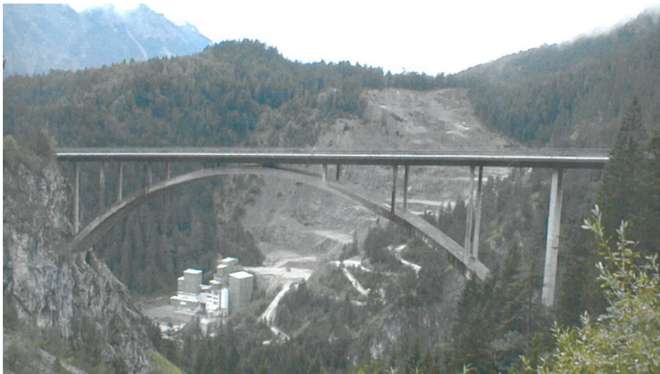
Gemstalbrücke im Jahr 2004, Planer: ARGE Hofstädter – Hofmann; Prüfenieur: Wicke
