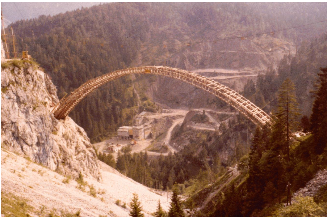
Gemstalbrücke: Aufbau des Cruciani-Lehrgerüsts Foto: Innerebner
